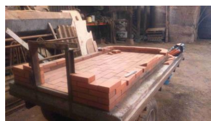
Construction de la voûte.
