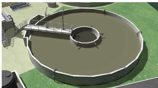
Entre temps, du chlorure ferrique (coagulant) est ajouté, afin d'alourdir les fines de boues pour faciliter leur décantation, afin de respecter les normes de rejet en phosphore. Le clarificateur séparera ensuite les boues de l'eau traitée, par un procédé de décantation. L'eau traitée est ensuite renvoyée vers le point de rejet.
